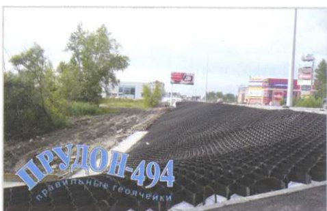
Укрепление откосов автодороги, г.Тюмень
